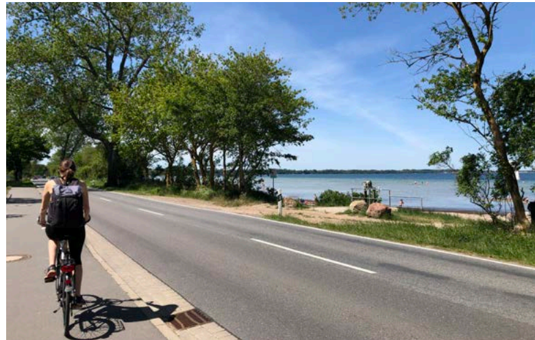
Asphaltierter Radweg mit unmittelbarem Blick auf die Wohlenberger Wieck
